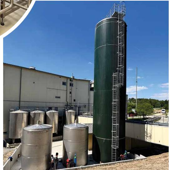
*Was für den Laien wie ein unüberblickbares Durcheinander von Rohren, Leitungen und Technik-Sammelurium aussieht, ist tatsächlich ein Musterbeispiel für modernste Umwelttechnologie in der Passauer Hefefabrik. Oben die Umkehrosmoseanlage zur Wasseraufbereitung, in der Mitte die Wärmerückgewinnungsanlage zur umweltschonenden Warmwassererzeugung und unten eine Luftaufbereitungsanlage für Würfelhefe.*
