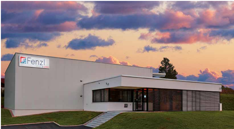
Die Firma Fenzl Wasser & Wärme in Untergriesbach
