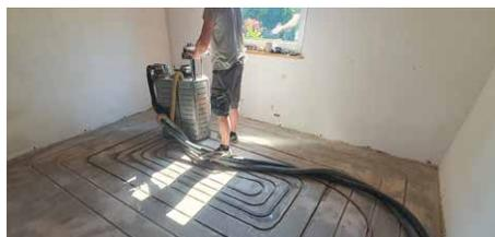
Mit einem speziellen Frässystem lässt sich nachträglich effizient und sauber eine Fußbodenheizung einbauen, dabei werden präzise Kanäle für Heizrohre, die direkt und sicher im Boden verlegt werden, in den vorhandenen Estrich gefräst.
