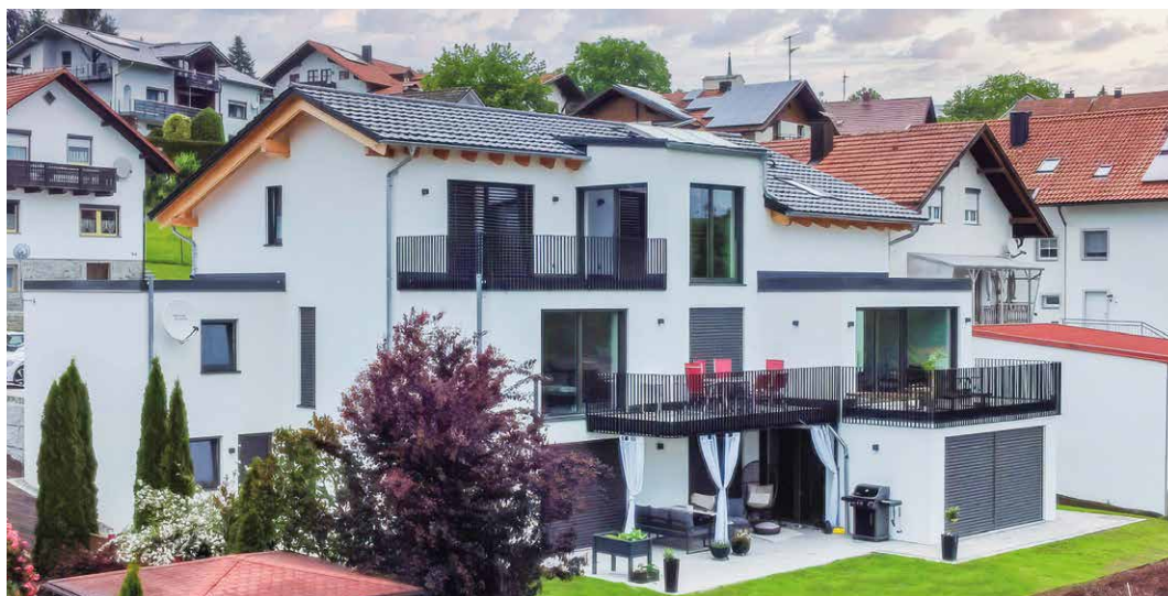
Die kluge und umsichtige Nutzung von Flächen, ein ökonomisch strukturierter Baukörper und die Wahl der richtigen Materialien sparen Kosten. Mit der Hilfe eines erfahrenen Planers lassen sich Wohnträume so immer noch realisieren.
