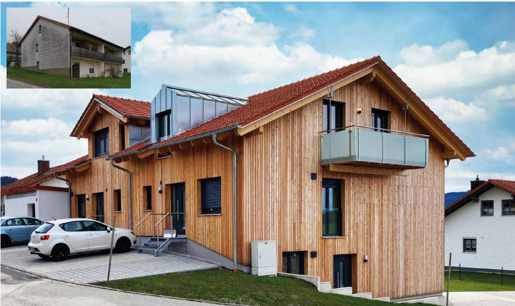
Als alt (oben) mach neu (unten): Wer das Potenzial in bestehender Bausubstanz erkennt, kann auch einen vermeintlich herunter gekommenen Altbau in eine attraktive, zeitgemäße und energieeffiziente Wohnimmobilie verwandeln.
