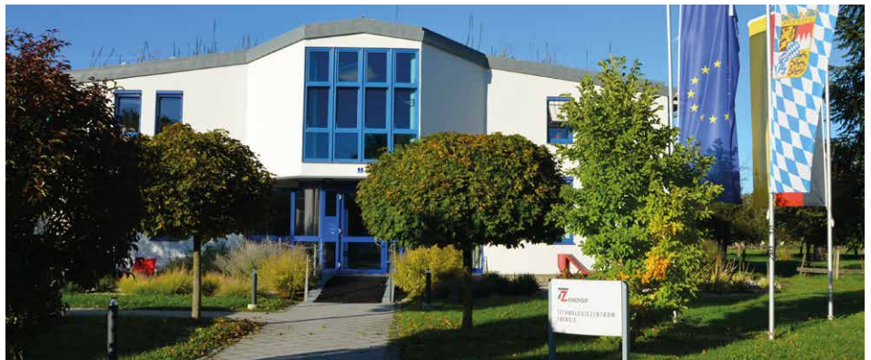
Das Technologiezentrum Energie in Ruhstorf ist eine Forschungseinrichtung der Hochschule für angewandte Wissenschaften in Landshut.
